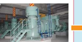
地下深くまで流れていった下水を一度くみ上げてから、もう一度下水道管に流し、水再生センターまで自然に流れるようにしています。
