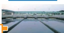
処理した水をトイレ用水などに再利用するため、砂の層を通して、よりきれいな「再生水」をつくります。
