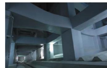
▲芝浦水再生センターの地下にある雨水貯留施設。25mプール約160杯分の雨水をためることができる。
